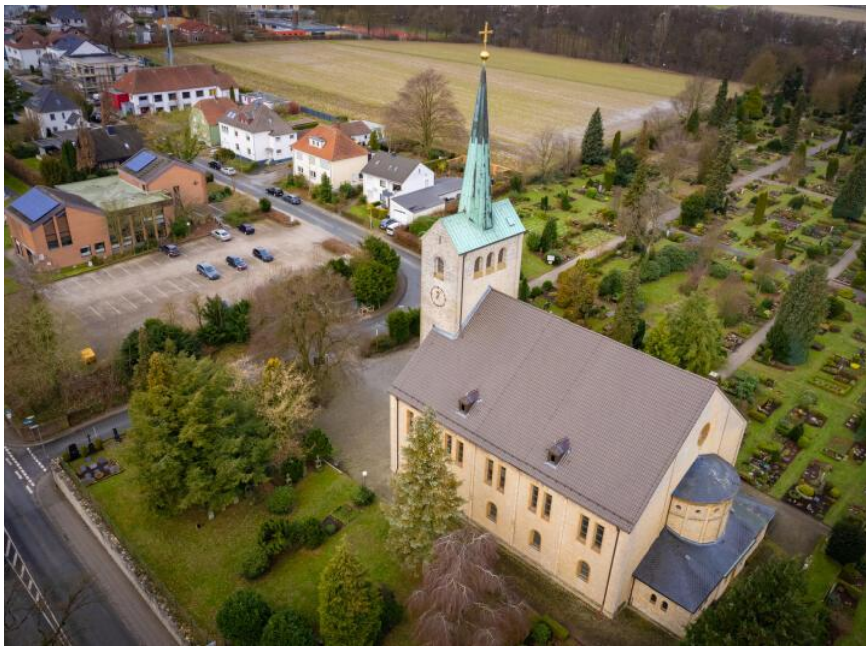
An die denkmalgeschützte Marienkirche in Jöllenbeck (Baujahr 1854) grenzen der Friedhof (r.) und das Gemeindehaus (links oben).
